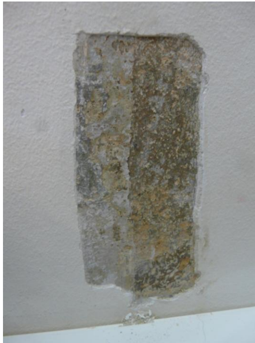
Odkrywka lamperii ściany.
