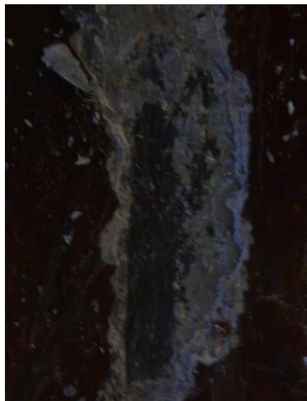
Odkrywka na metalowej balustradzie
