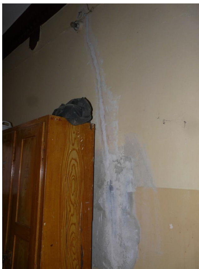
Fot. 16. Wtórne uzupełnienie tynku.
