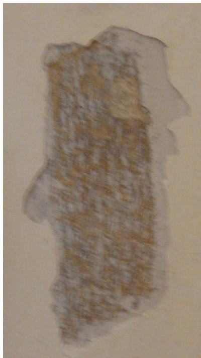
Odkrywka obramienia tablicy.
