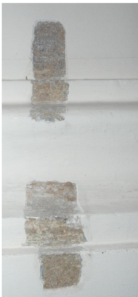
Odkrywka cokołu ściany z tablicą.
