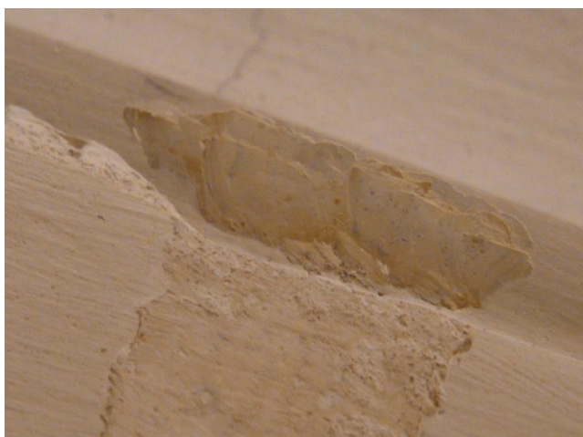
Fragment odkrywki gurtu sklepiennego nad schodami- widoczne fragmenty ugru.
