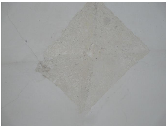
Odkrywka na sklepieniu korytarza
