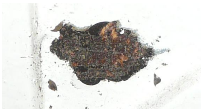
Odkrywka na drzwiach wejściowych
