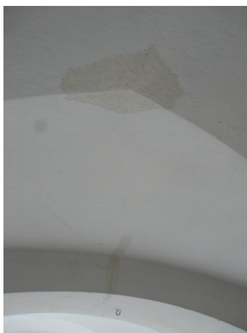
Odkrywki na wysklepce i gurcie sklepienia gwiazdowego.
