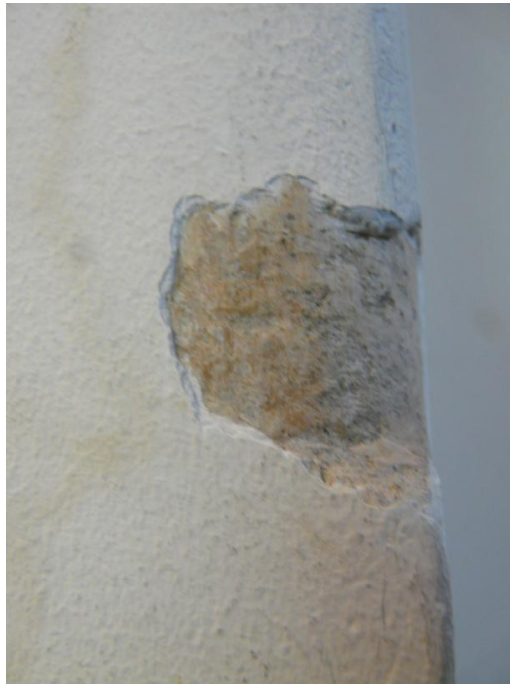
Odkrywka na narożniku pilastra (metalowa listwa)
