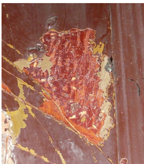
Odkrywka na drzwiach wejściowych.
