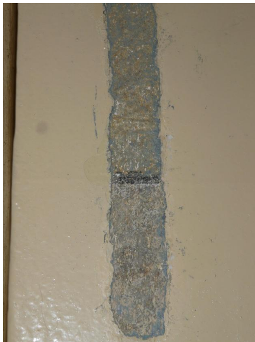
Odkrywka na ścianie przy portierni
