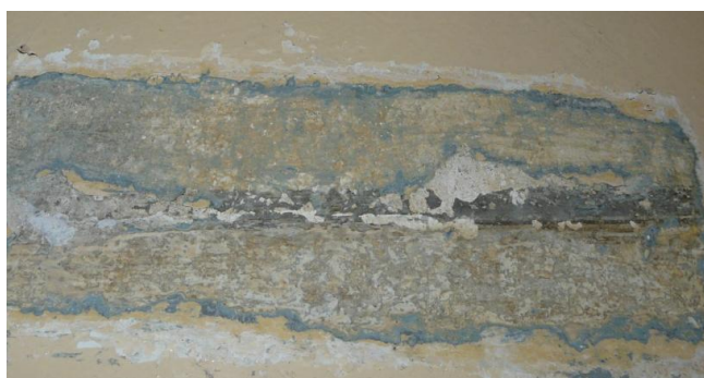
Odkrywka na ścianie
