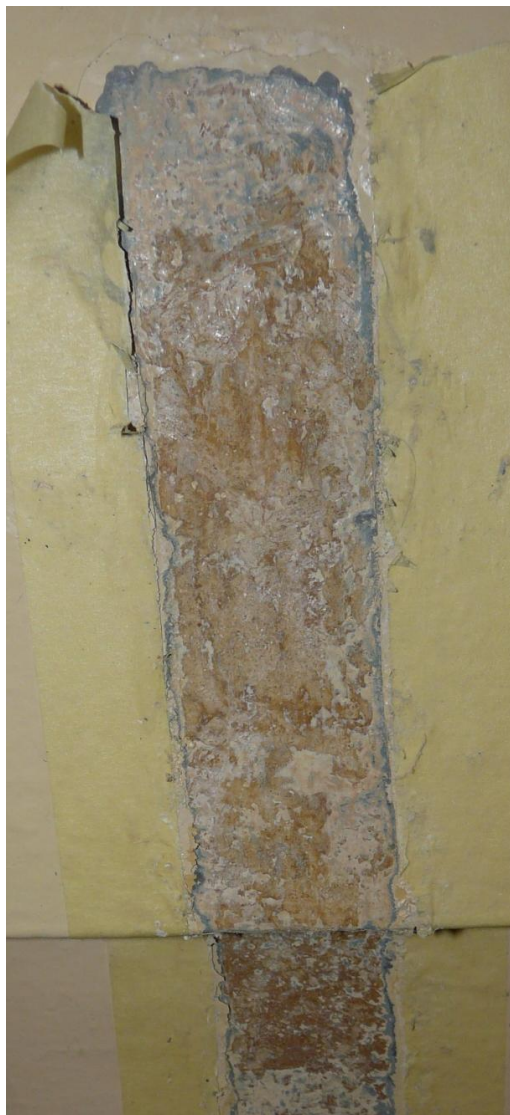
Odkrywka na fragmencie ściany przy schodach- tablica i jej obramowanie
