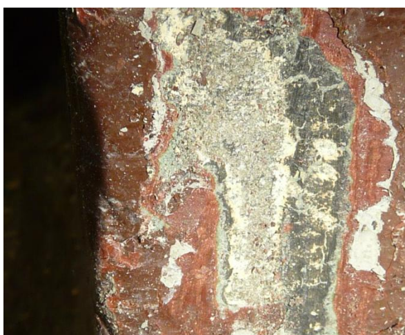
Odkrywka na cokolicu korytarza
