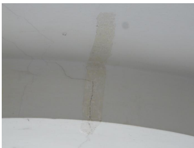
Odkrywka na wysklepce i gurcie sklepienia korytarza.
