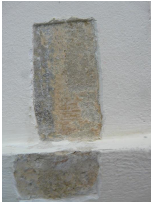
Odkrywka dolnej części pilastra.
