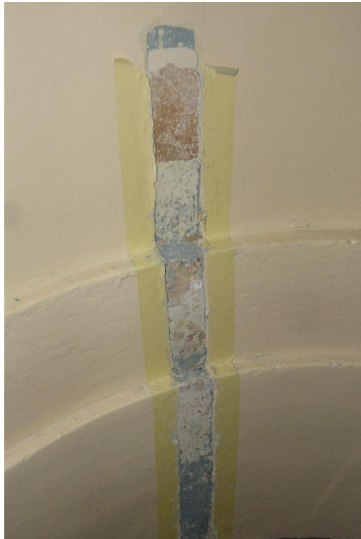
Odkrywka na pilastrze łukowym.
