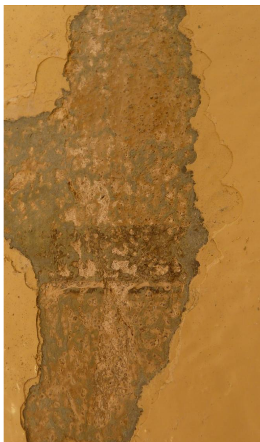
Odkrywka na ścianie przy oknie
