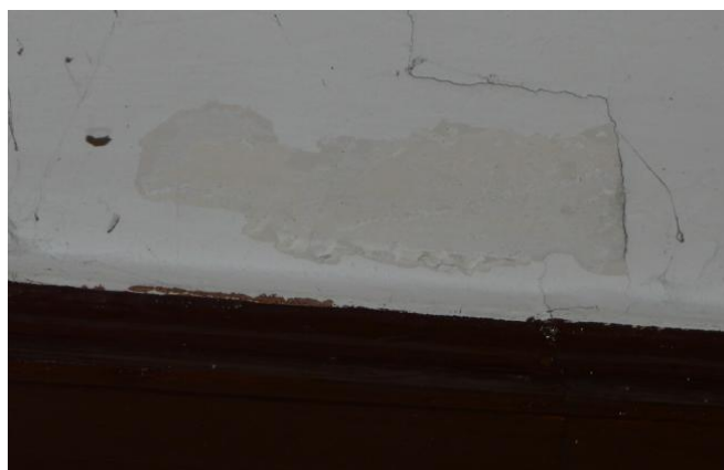
Odkrywka na suficie
