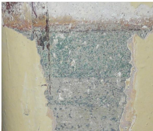
Odkrywki na ścianie
