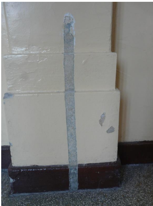
Odkrywka na pilastrze- NCS S 1015-Y30R
