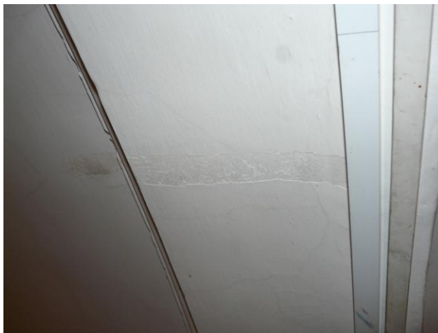
Fragment gurtu sklepiennego nad schodami holu.
