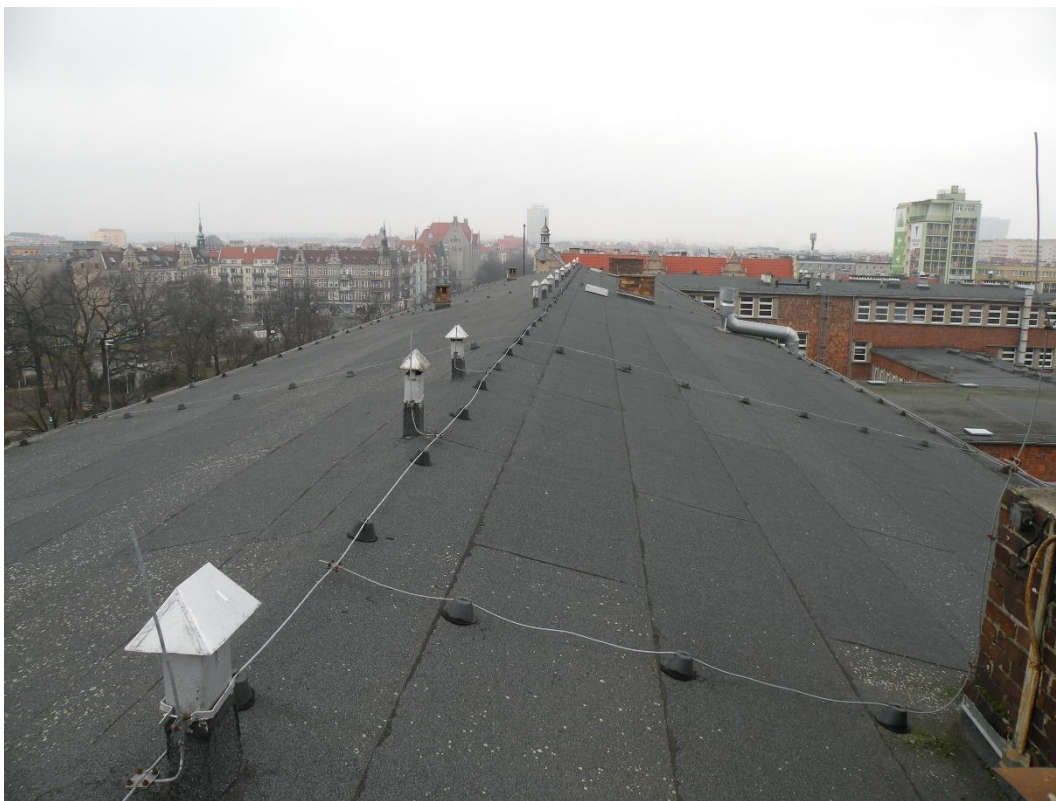
Fot. 9. Dach segm. A
