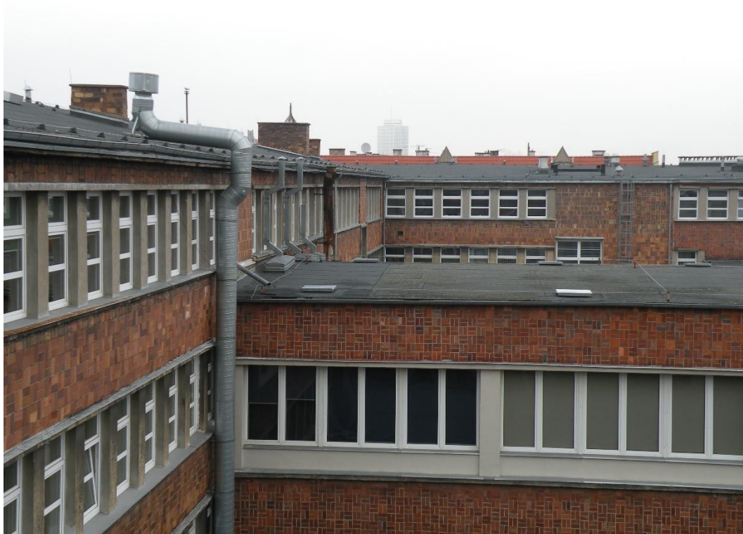
Fot. 6. Dachy H i A, w tle dach B i C
