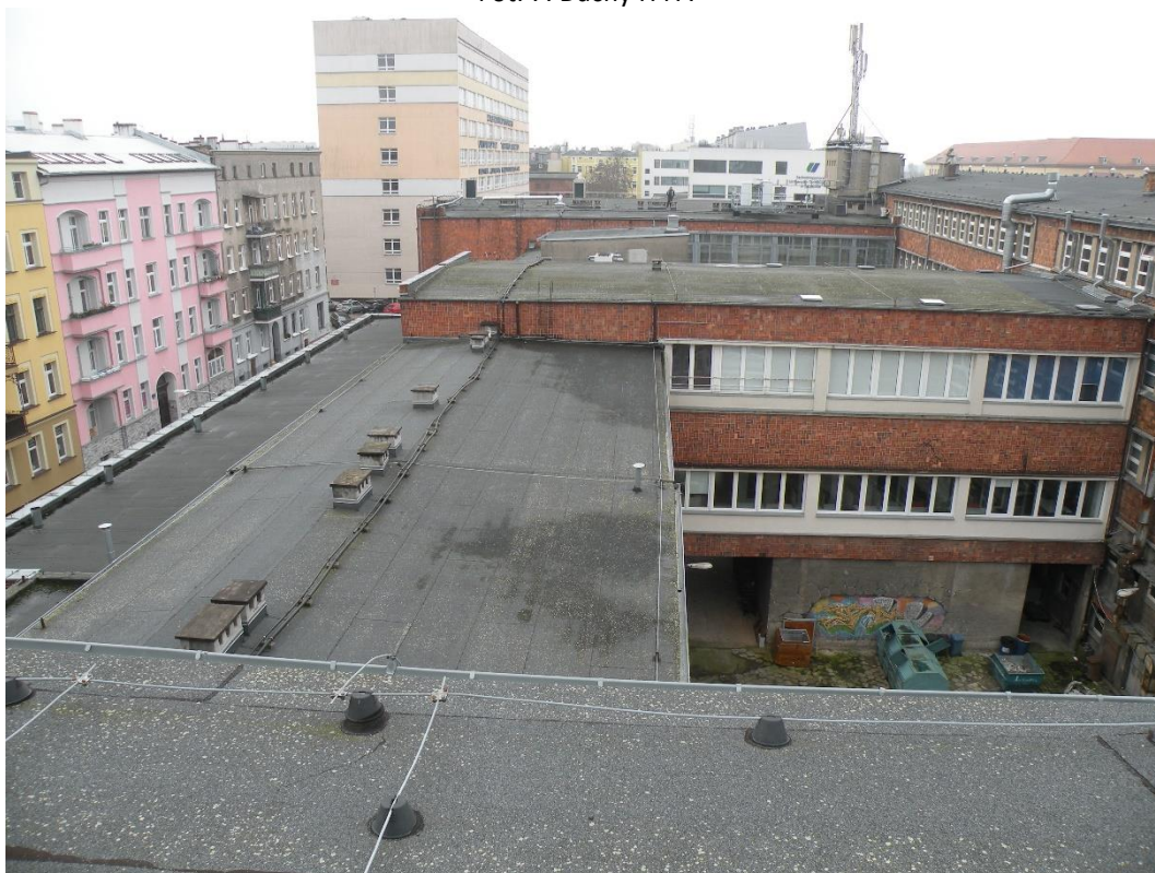
Fot. 8. Dachs – widok z dachu C wzdłuż segm. E, D, F w kierunku na segm. G
