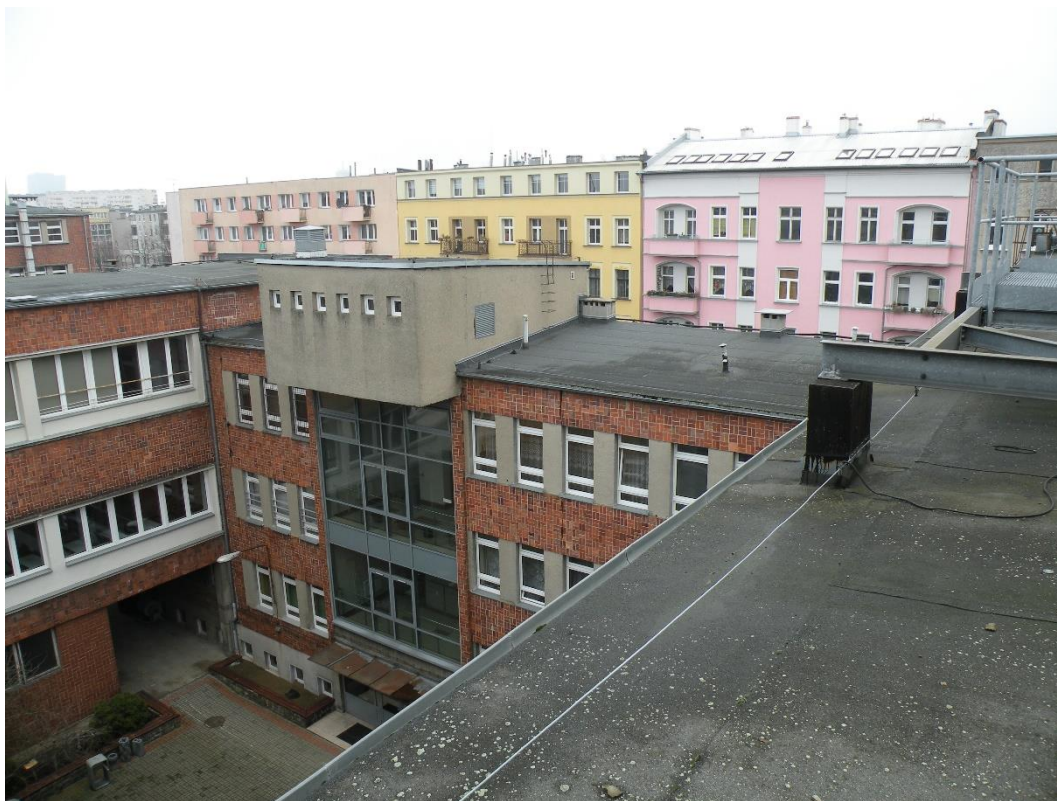
Fot. 5. Dachy D, E, F
