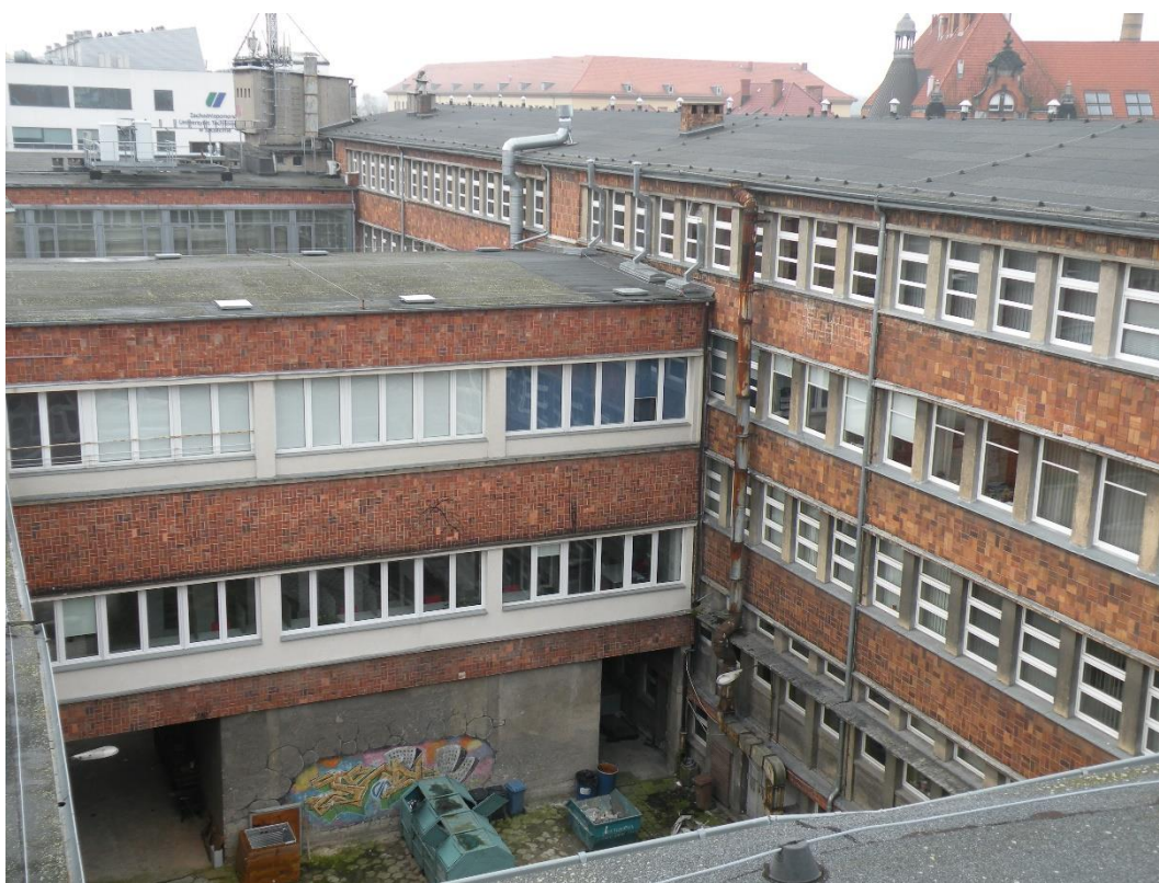
Fot. 7. Dachs H i A
